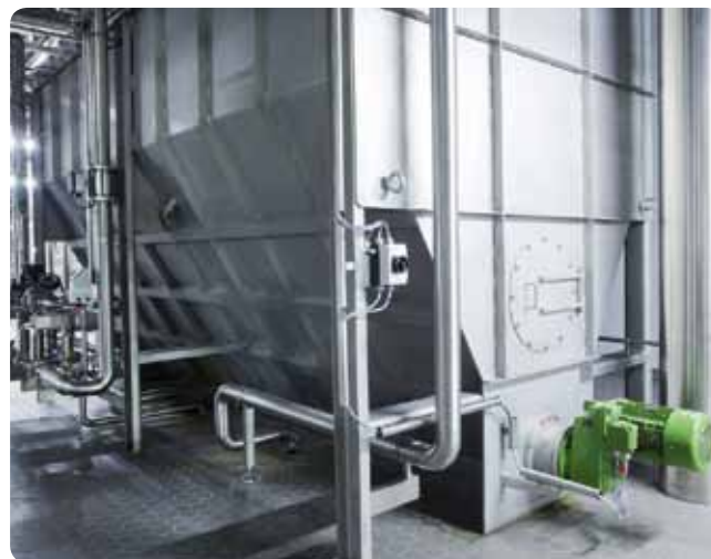
Plochá elektroprevodovka poháňa závitový dopravník
