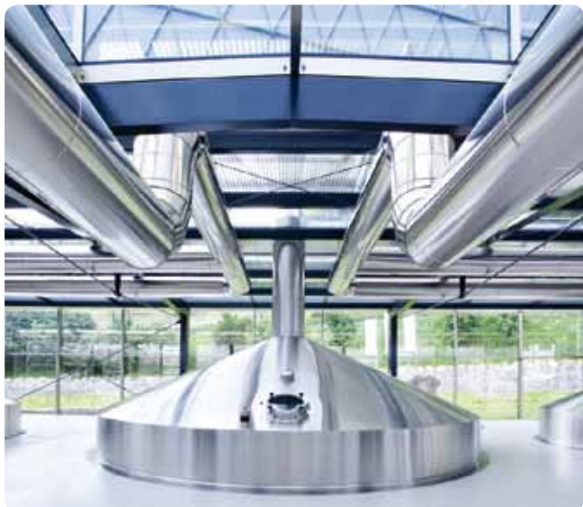
Srdcom varne je sciedzacia nádrž s priemerom 8,6 metra
